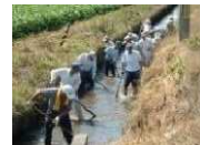
水路の泥上げ
