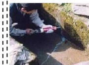
水路のひび割れ補修
