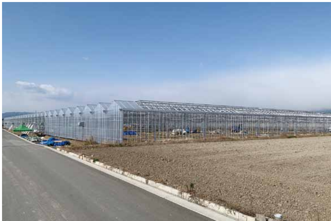
次世代型園芸ハウスの建設が進む国営南国地区(能間工区)
