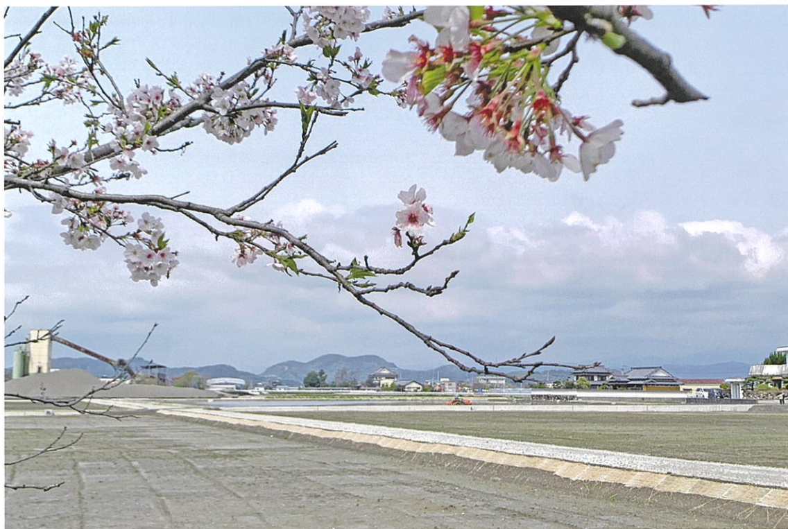
田植えの準備が始まった「下島工区」（国営緊急農地再編整備事業 高知南国地区）
