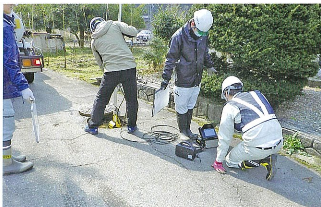
管口カメラによる管路内の調査
