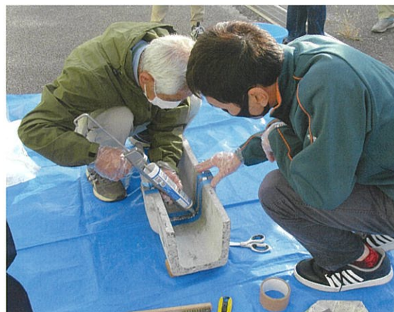
屋外で補修実技をする参加者 （コーキング材の充填）
